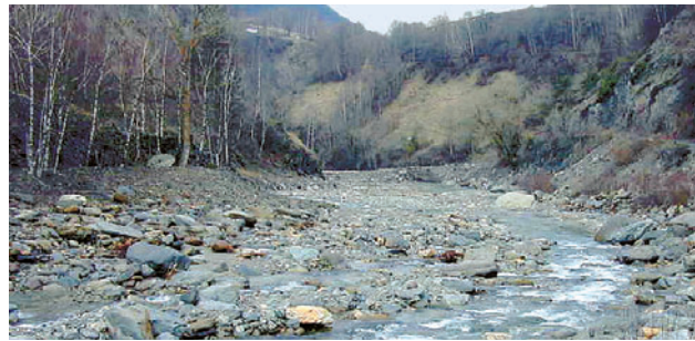
Leere obere Geschiebekammer im Grindji (Foto in Fließrichtung, Aufnahme vom 10.2.2000)
