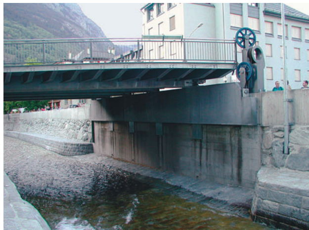
Saltina-Hubbrücke hochgezogen (wie bei einem Hochwasserereignis)
