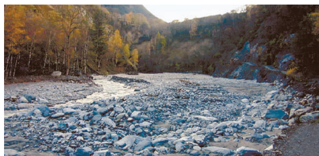
Gefüllte obere Geschiebekammer im Grindji (Foto in Fließrichtung, Aufnahme vom 4.11.2000)
