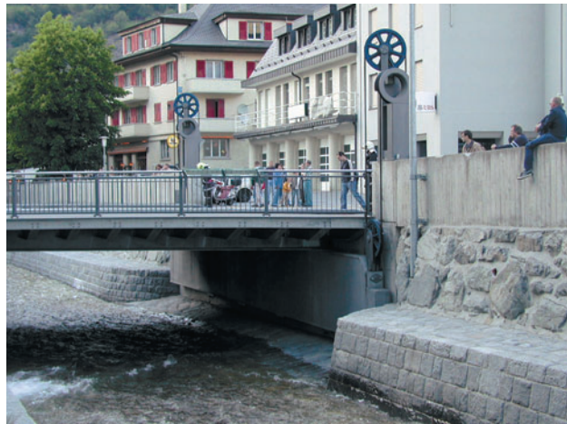
Saltina-Hubbrücke im Normalzustand, nicht hochgezogen
